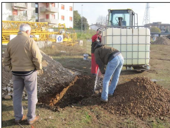
Approntamento della prova di carico
